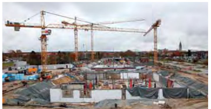
Die Baustelle an der Breitenau im Norden der Domstadt
